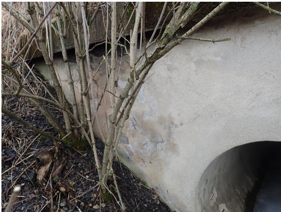
Foto 3: Výluhy, degradace omítky na čele propustku
